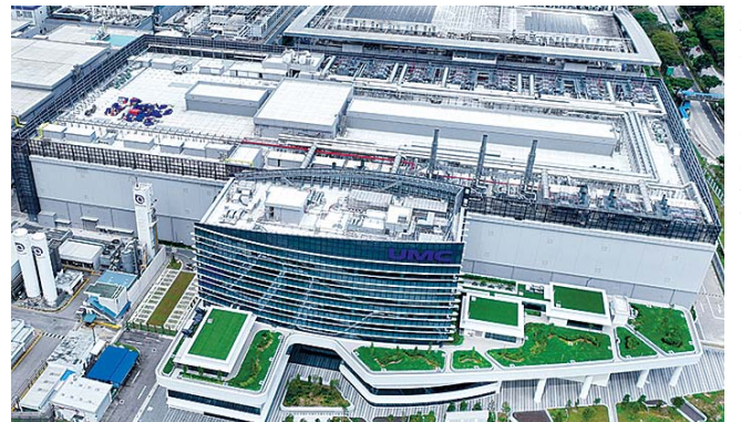
事務所棟。外装はカーテンウォールで構成し、自然光が入る
